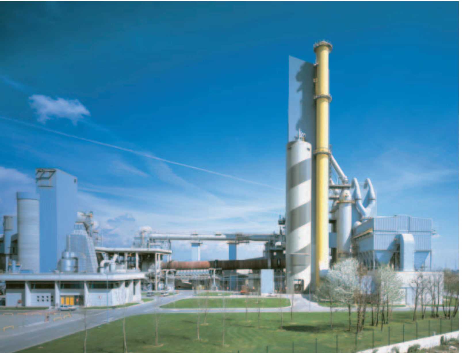
La nuova cementeria di Calusco d'Adda. The new cement plant in Calusco d'Adda.
